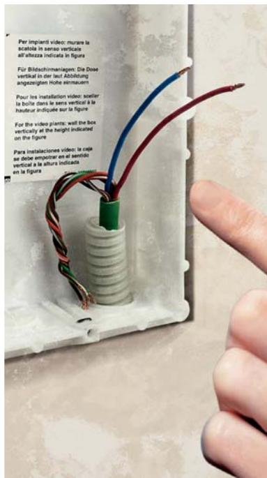
Utiliza dos de los cables para instalar el nuevo frente de calle.
